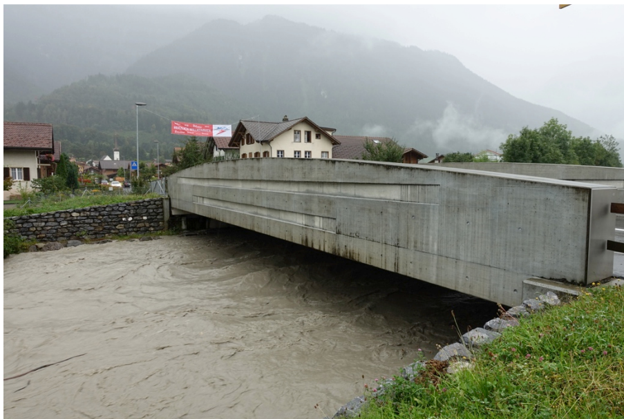
Legende: Untere Bönigbrücke über die Lütschine in Bönigen beim Hochwasserereignis vom 05. September 2016. Foto: Mätzener & Wyss Bauingenieure AG.
