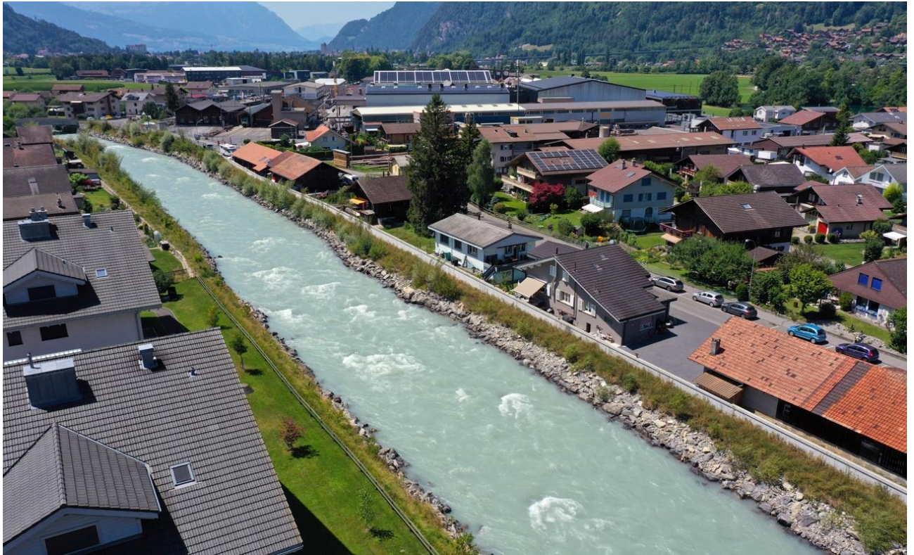
Ersetzter Blocksatz mit erhöhter Rauigkeit in Bönigen (Foto: Flussbau AG, 2022)
