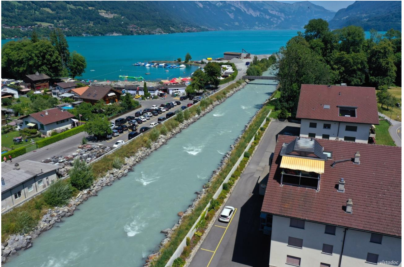
Ersetzter Blocksatz mit erhöhter Rauigkeit in Bönigen (Foto: Flussbau AG, 2022)
