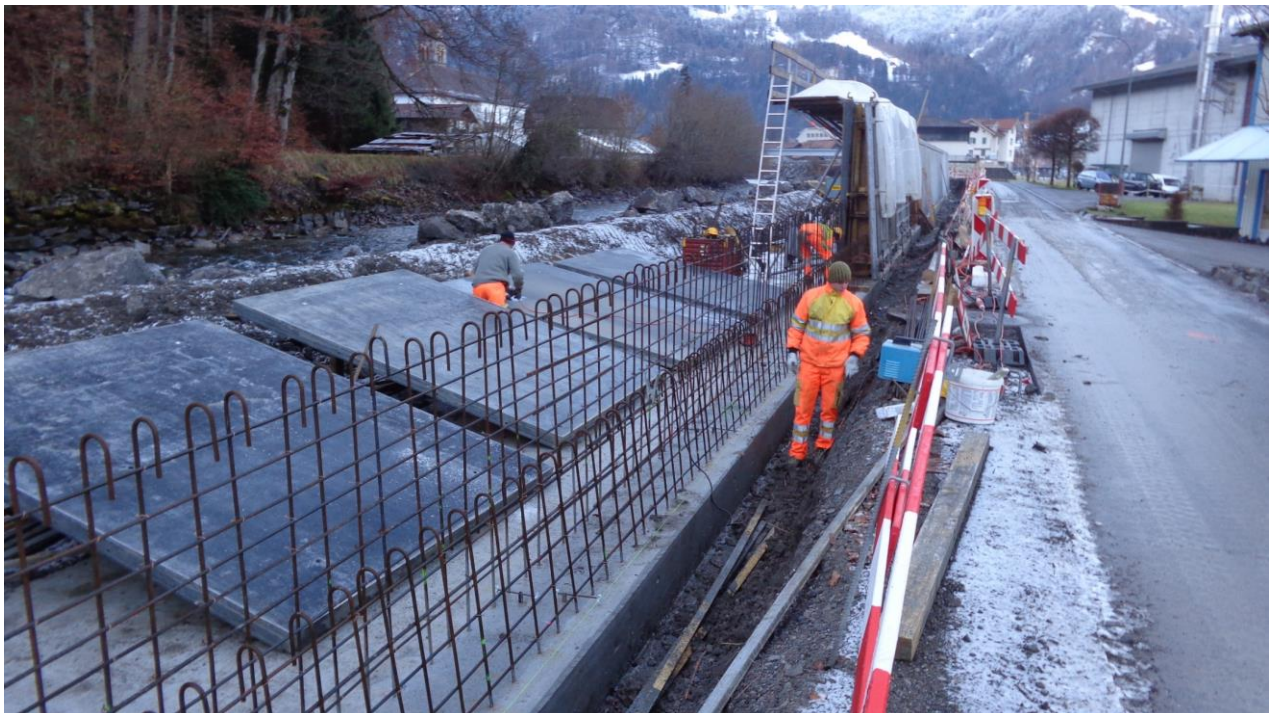
Sicherstellung Hochwasserschutz mit Winkelstützmauer in Ortbeton
