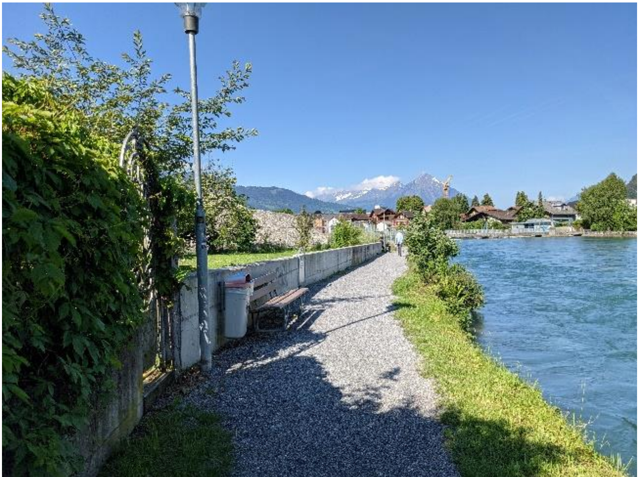
Hochwasserschutzmauer unterhalb der Kanalpromenade (Foto; Kissling + Zbinden AG, 2018)
