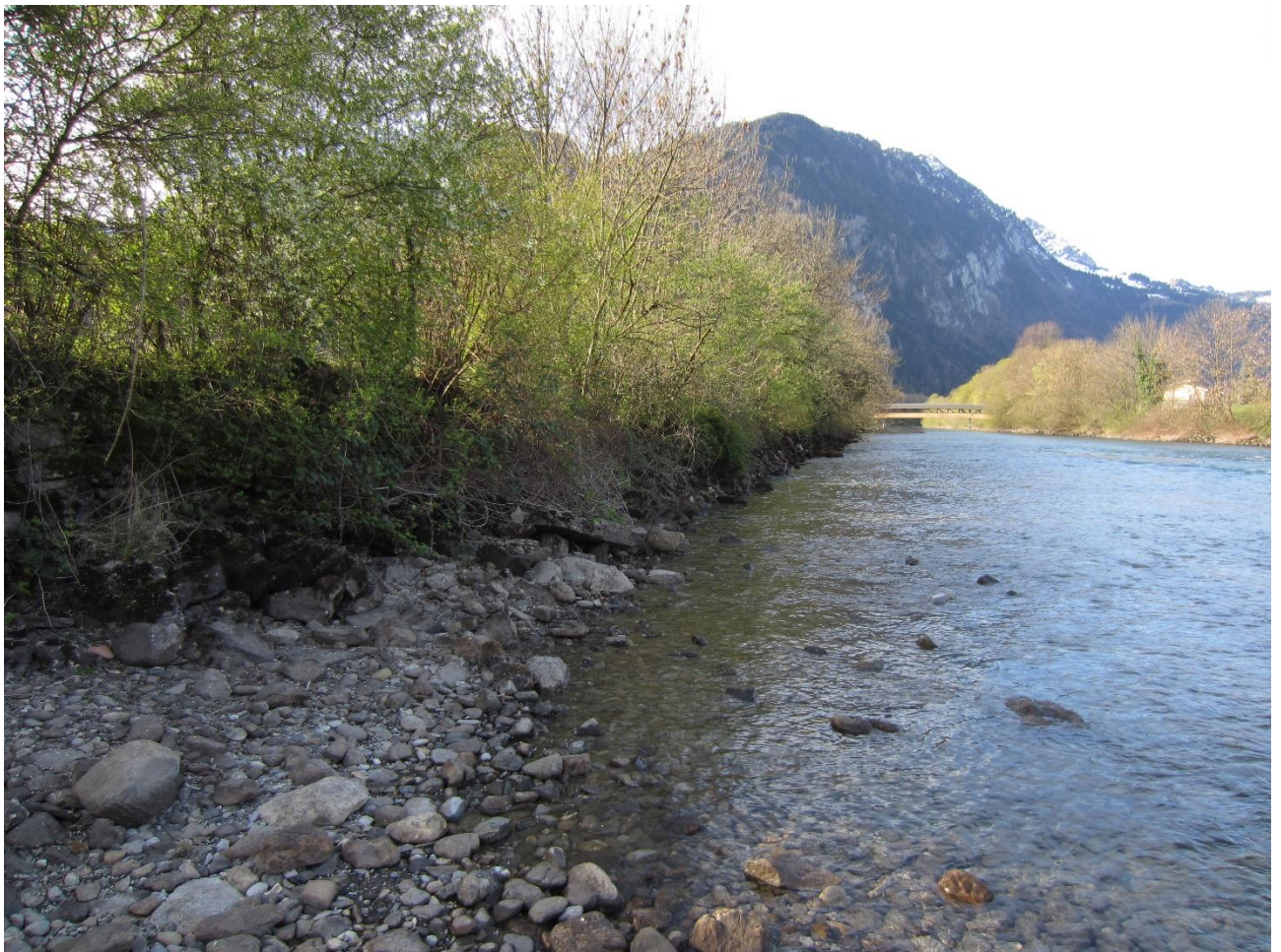
Ufer vor der Bauausführung (Foto; Kissling + Zbinden AG, 2014)
