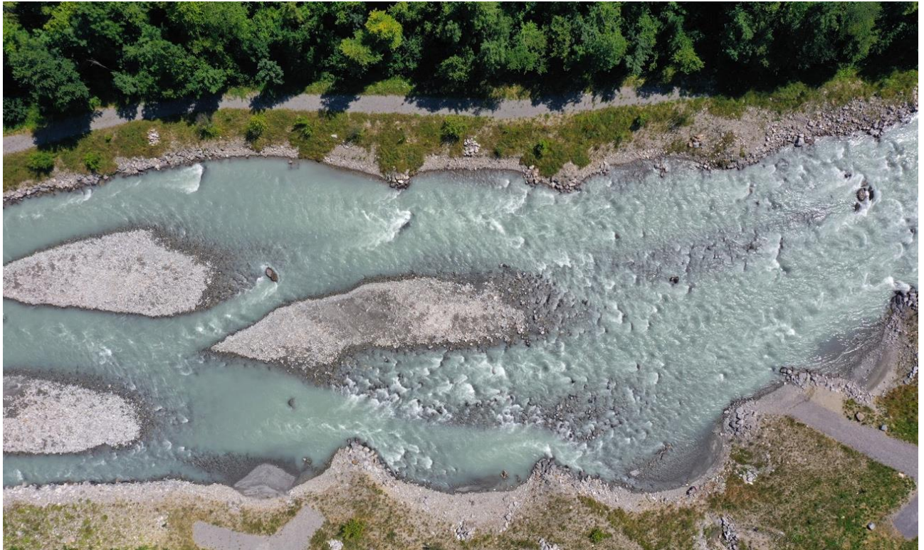
Aufweitung Obereyli für den Geschiebe- und Holzrückhalt (Foto: Flussbau AG, 2022)
