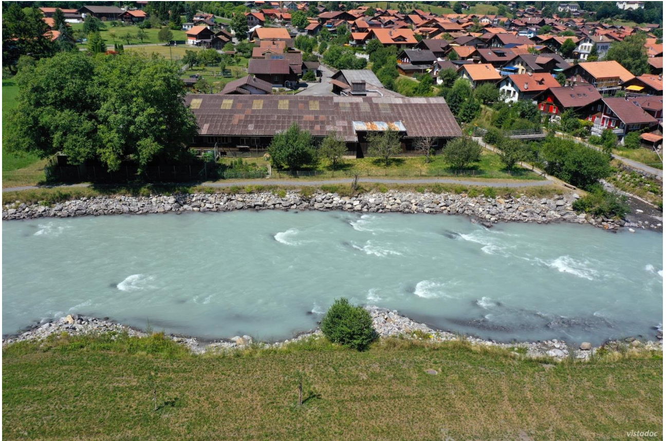
Gerinneausbau auf ein HQ_{100} und Erhöhung Strömungsvariabilität (Foto: Flussbau AG, 2022)
