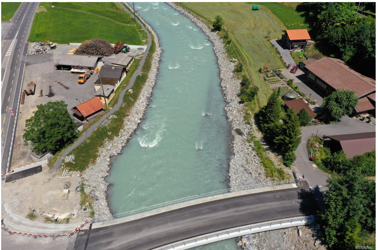
Gerinneausbau auf ein HQ 100 und Einstausicherung Gsteigwilerbrücke (Foto: Flussbau AG, 2022)
