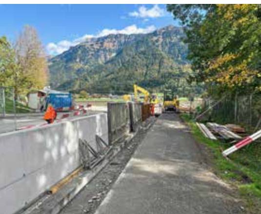
Mauerergänzung AVAG (Baulos 1)
