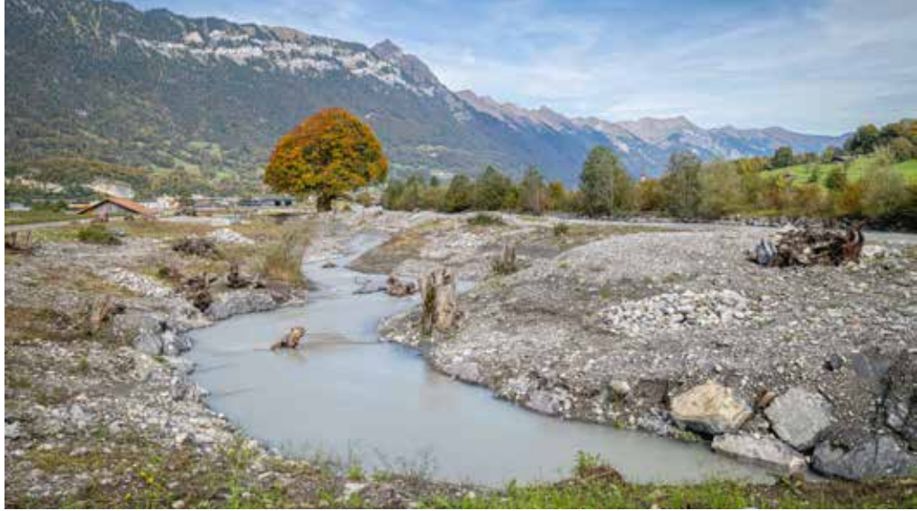
Seitengerinne und Uferstrukturen Teilprojekt 3
