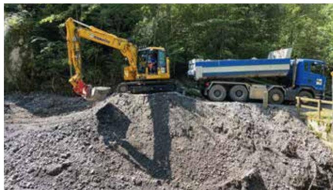
Räumungsarbeiten Gerinne Erschwandenbach
