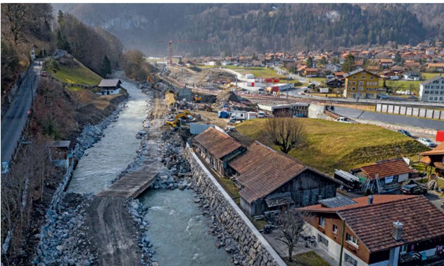
Das Ufer zwischen der Allmend und der Avari wird saniert und gesichert, die Ufermauern erhöht und es wird ein Entlastungsbauwerk realisiert. Gearbeitet wird von Baupisten im Gerinne aus. Zur logistischen Erschliessung unterhalb der Hubbrücke Gsteig musste sie zeitweise angehoben werden.
